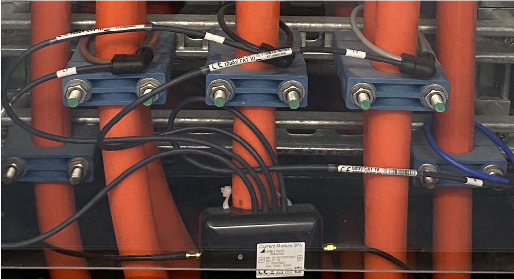
Das Anschlussgehäuse eines Current Modules kann mit Kabelbindern direkt auf einem Kabel fixiert werden.
