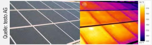
Thermogramm der Anschlussdosen
