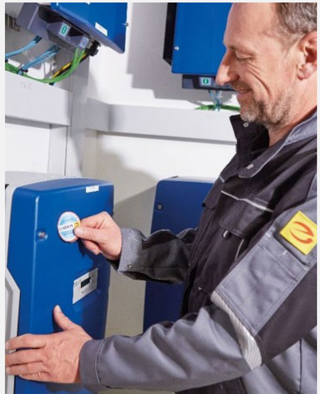
Anlage ist geprüft, Prüfsiegel aufbringen
